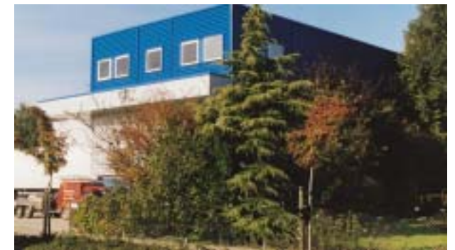
Uitbreiding in de hoogte.
