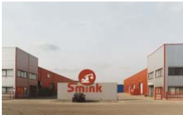
Buitenopslag op verantwoorde manier afschermen.
